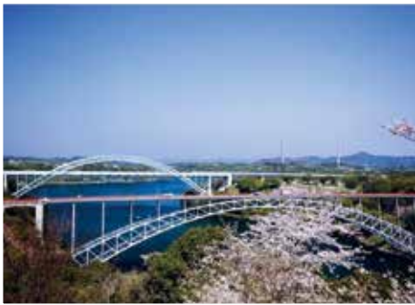
針尾電波塔と西海橋
